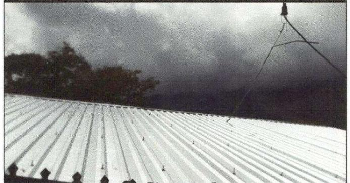
Foto 2: Cambio de lmina por lamina troquelada módulo de aulas y cocina (28mts de largo y ancho 14 mts)
