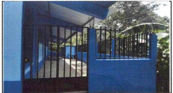
Foto 4: Sustitución de portón de metal ingreso principal, (alto 2 metros y ancho 2.55 metros.)
