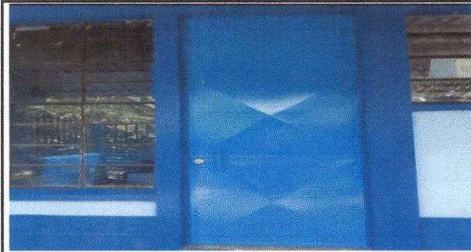
Foto 1: Sustitución de puertas de metal módulo de aulas y cocina.
